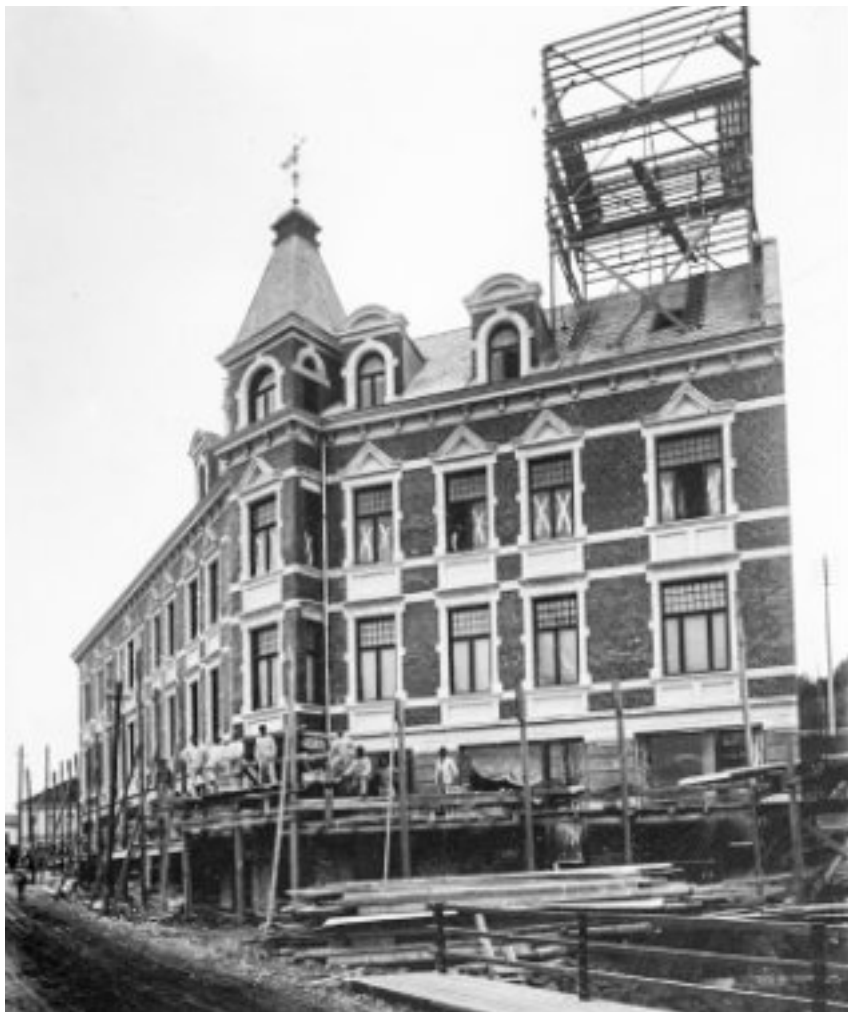
Fossveien 1 under oppføring.
